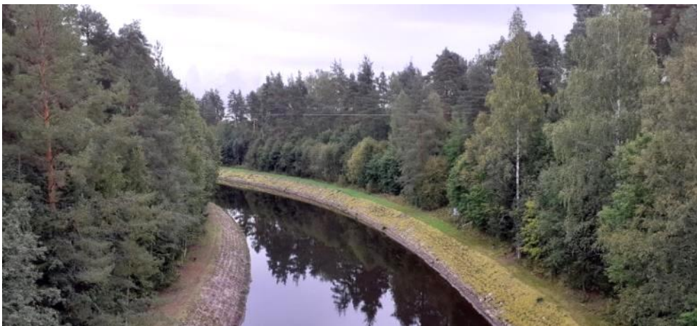
Kuva 44. Ahkiolahden vanha kanava pohjoiseen kuvattuna (AJ).
