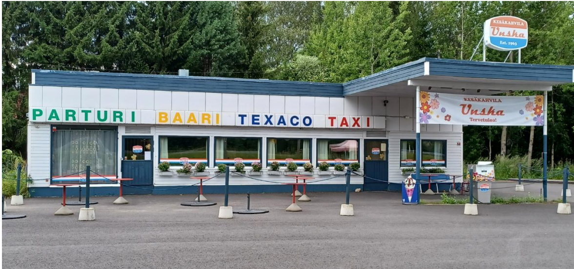
Kuva 23: Vanha huoltoasemarakennus. (Kuva: Annaelina Isola, Pohjois-Savon liitto (2023).
