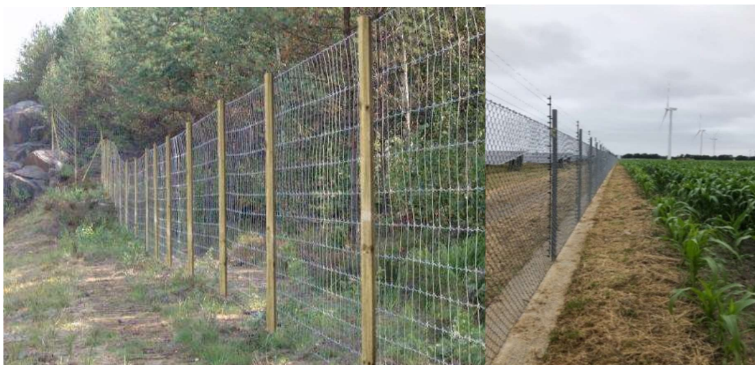
Kuva 2. Esimerkki riista-aidasta, jossa on puupylväitä (kuva vasemmalla) ja teollisuusaidan rakentaminen sisäpuolisella kiipeilysuojalla sähköjohdoista (kuva oikealla).
