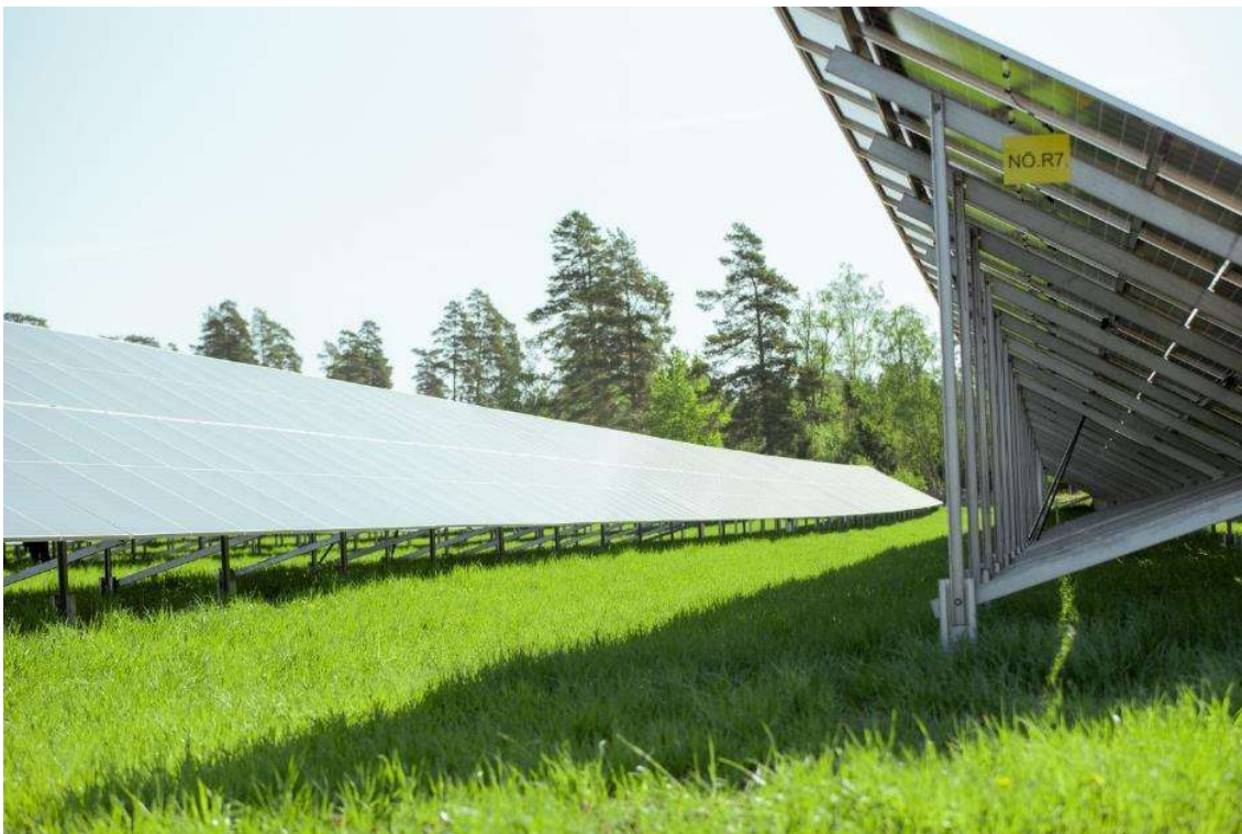
Kuva 4. Aurinkokennomoduulit seisovat pitkissä riveissä, noin 5-6 metrin päässä toisistaan, paneelien alla voi kasvaa ruohoa ja muita kasveja. Maa ei siis ole kovettunut, mikä mahdollistaa hulevesien tunkeutumisen.
