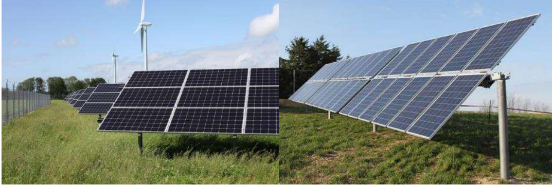
Kuva 3. Esimerkki piiaurinkokennomoduuleista, joissa on alumiinirunko maatelineessä (vasemmalla). Kuvassa Varbergs Energin Solsidan-puisto Tvååkerissa. Esimerkki aurinkokennomoduuleista yksiakselisissa aurinkoseurantajärjestelmissä (oikealla).
