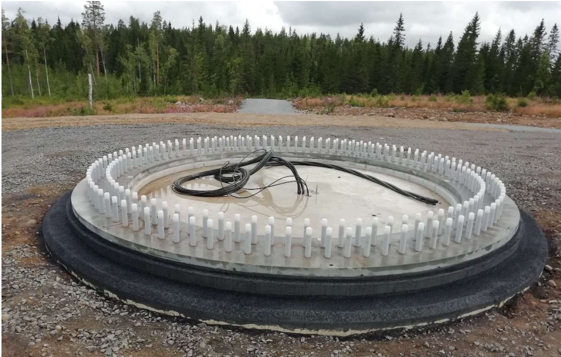
KUVA 31. Toteutettu esimerkki perustuksen maanpäällisestä osasta
