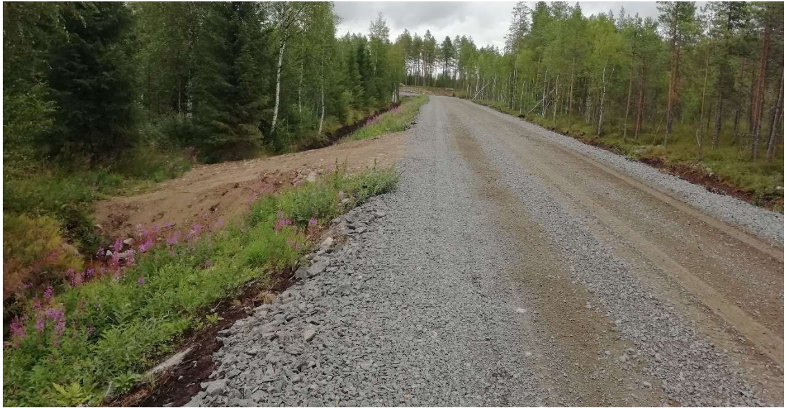
KUVA 32. Esimerkki toteutetusta tuulivoimalapuiston sisäisestä tiestä. Teiltä rakennetaan liittymät metsäpalstoille.
