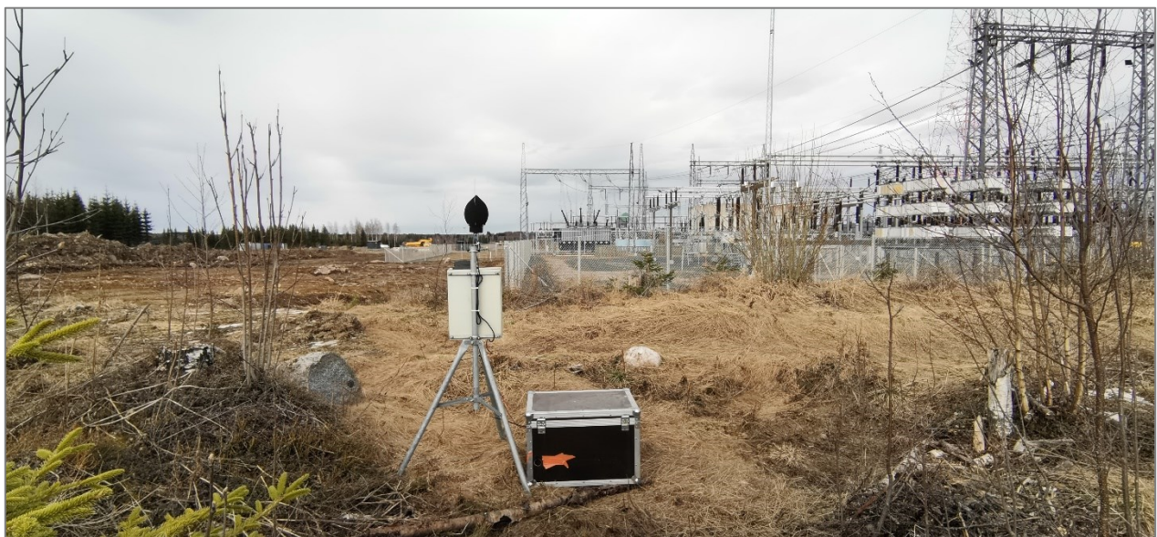
Kuva 3. Kuva sähköaseman vierisestä mittauspisteestä (MP1). Mittauspisteestä on suora näköyhteys sähköaseman muuntajiin ja reaktoreihin.
