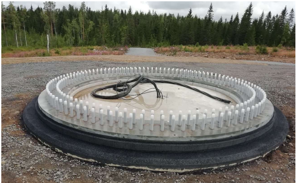
KUVA 31. Toteutettu esimerkki perustuksen maanpäällisestä osasta
