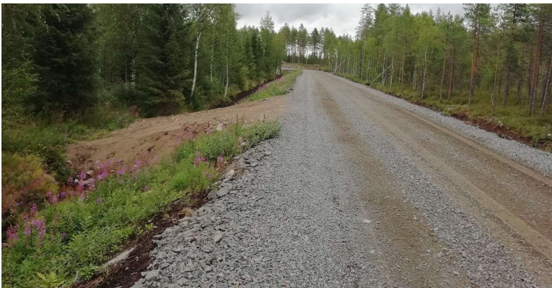
KUVA 32. Esimerkki toteutetusta tuulivoimalapuiston sisäisestä tiestä. Teitä rakennetaan liittymät metsäpalstoille.
