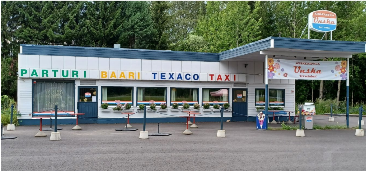
Kuva 23: Vanha huoltoasemarakennus. (Kuva: Annaelina Isola, Pohjois-Savon liitto (2023).
