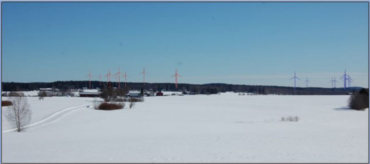
Kuva 70. Yhteisvaikutushavainnekuva Kirmanjärven länsipuolella sijaitsevalta peltoaukealta (kuvauspiste 5), joka sijaitsee noin 5,7 km etäisyydellä Tielammen alueen länsipuolella. Punaiset voimalat on Tielammen ja siniset Iso-Petäjämäen. © Envineer Oy
