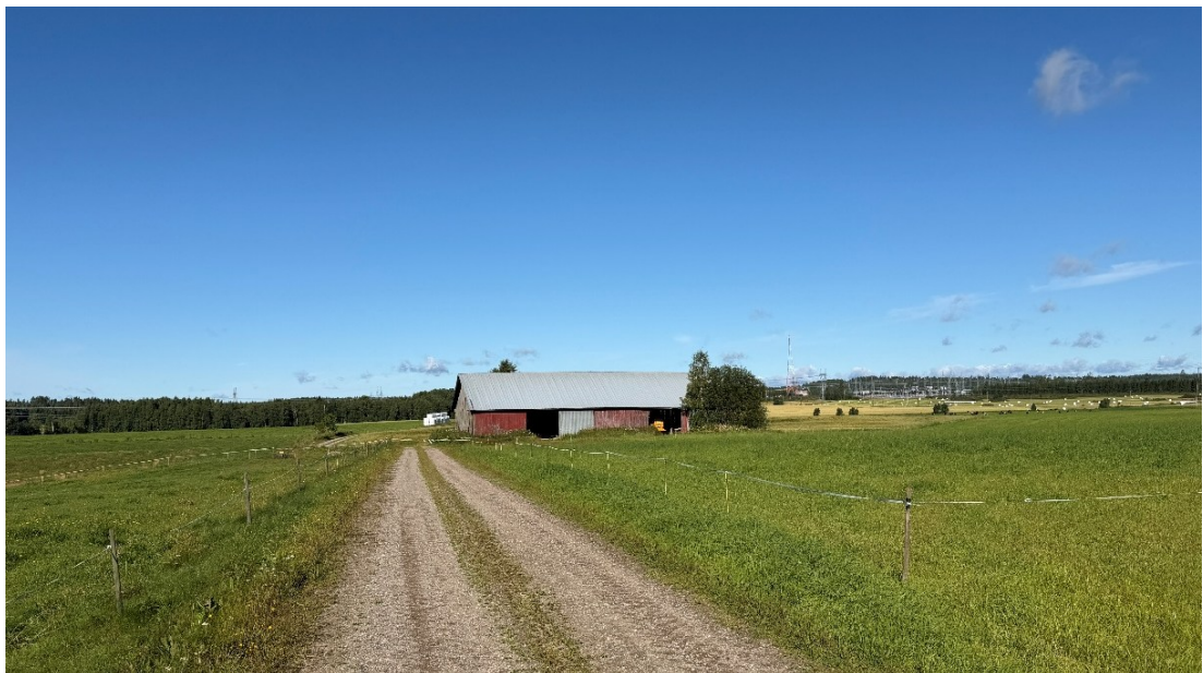
Kuva 8: Kuvassa suunnittelualueelle sijoittuva talousrakennus. Kuvassa taka-alalla Alapitkän sähköasema.
