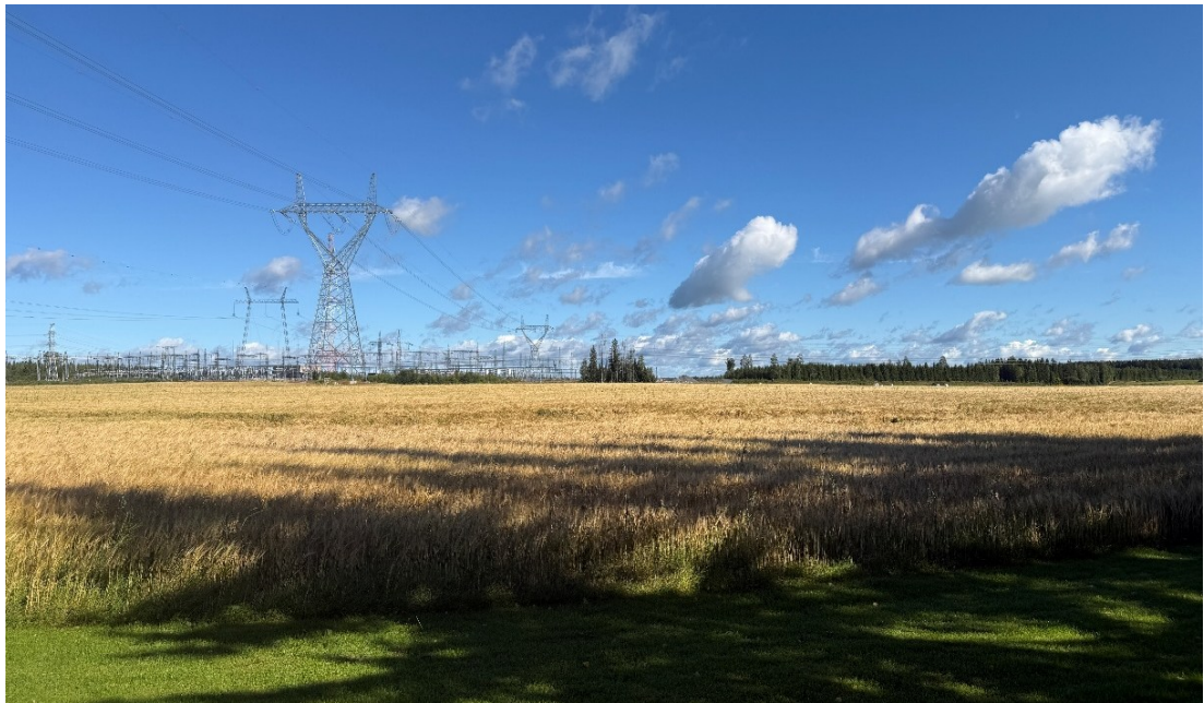
Kuva 4: Viljelymaisemaa, jossa erottuvat voimalinjat ja sähköasema.
