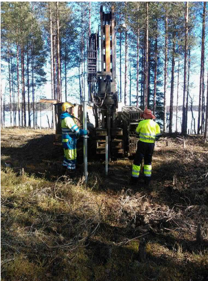
Kuva 4: Porakonekairaus ja havaintoputkiasennus. Kuva A. Eskelinen, GTK.
