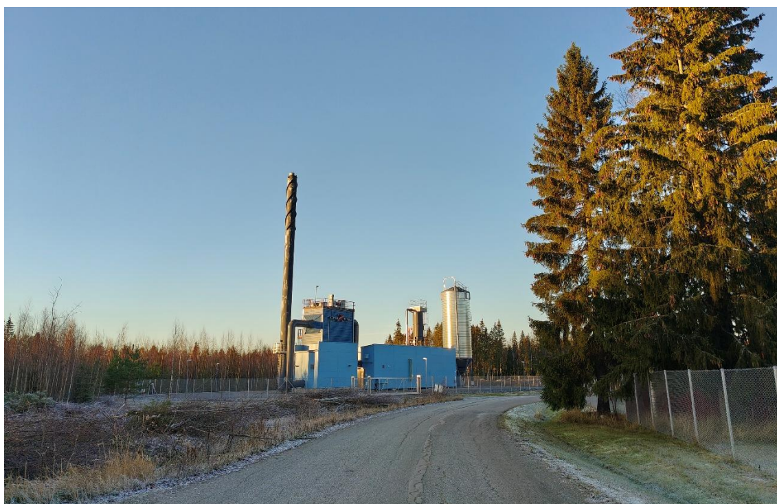
Kuva 12 Lämpölaitoksen rakennuksia. Kuva otettu Suoniementieltä luoteeseen.
