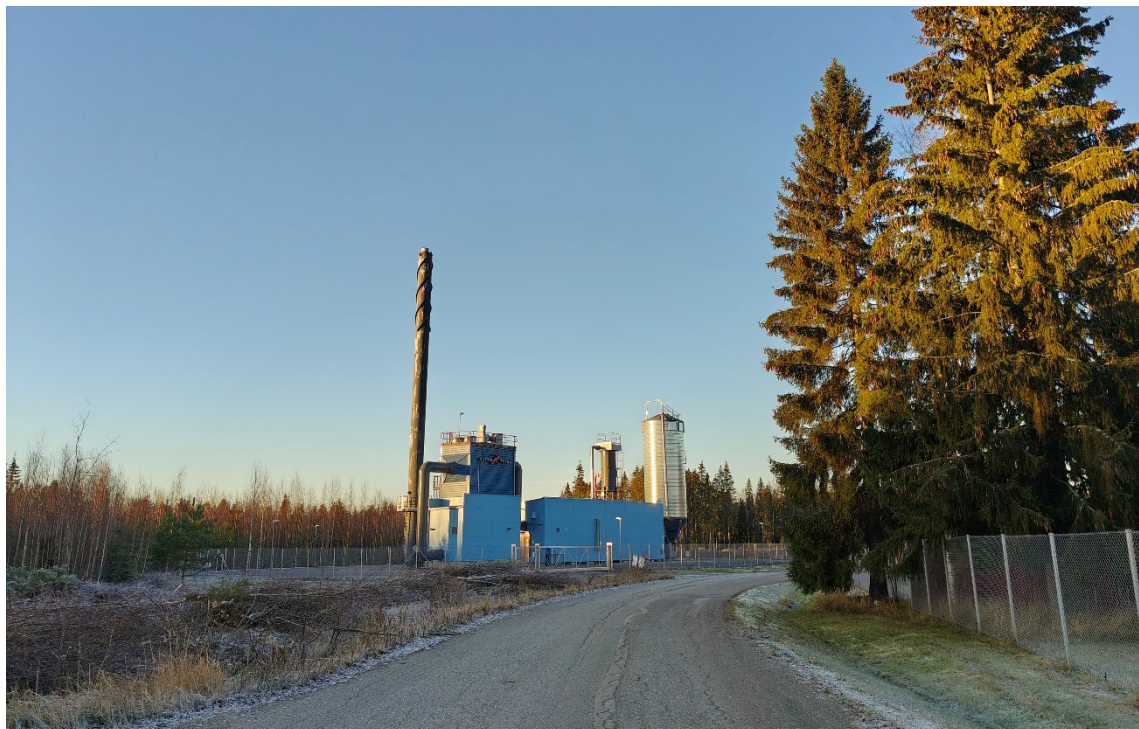
Kuva 12. Lämpölaitoksen rakennuksia. Kuva otettu Suoniementieltä luoteeseen.
